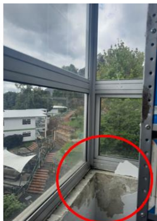
Signos de humedad y levantamiento de pintura en diferentes áreas.
