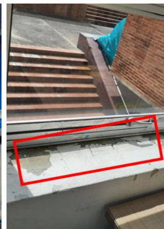
Signos de humedad y levantamiento de pintura en diferentes áreas.
