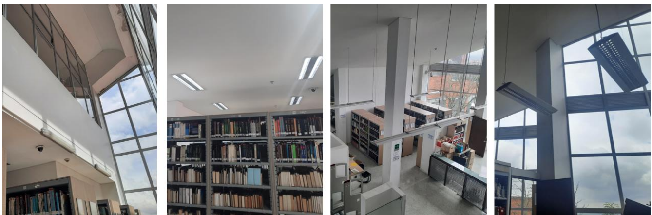
Registro fotográfico iluminación Biblioteca Macarena A Camilo Torres Restrepo.
