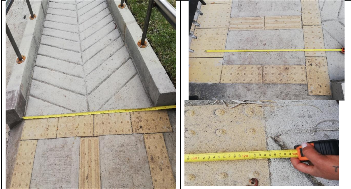
Figura 12. Inicio de la Rampa
