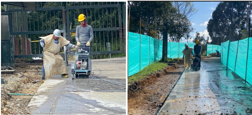
Figura 7. Corte y Demolición del Concreto
