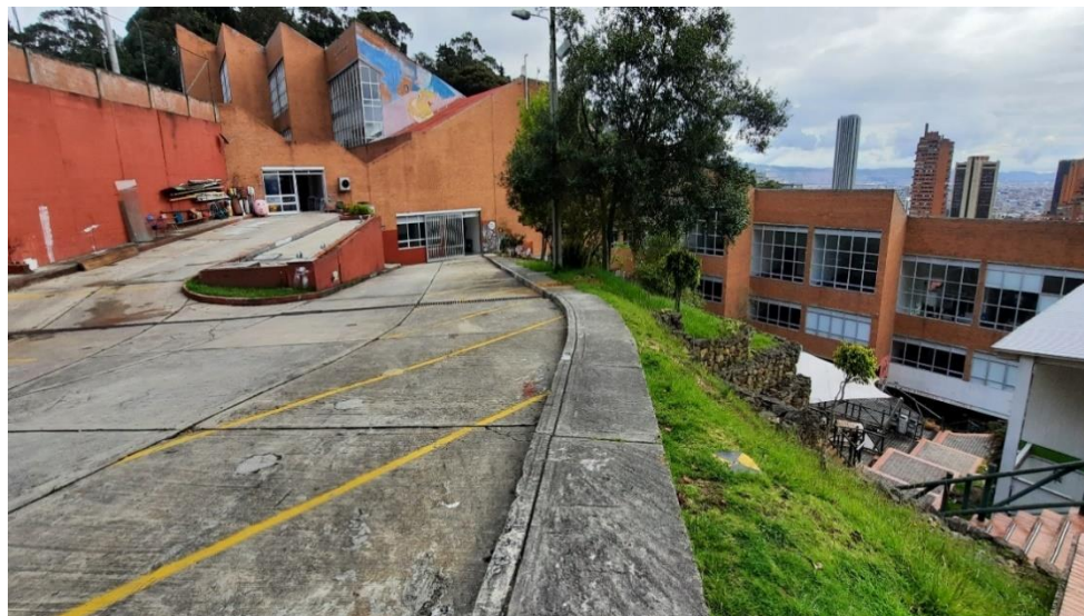
Figura 8. Área de Excavación
